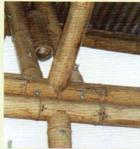
Estructura sobre soporte vertical con conexiones tipo "boca de pescado" y uniones mediante pernos metálicos.
