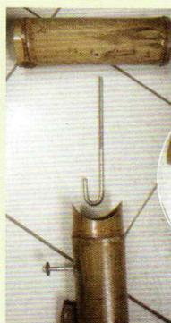
Conexión "boca de pescado" y pernos metálicos para fijación de caña horizontal con vertical.
