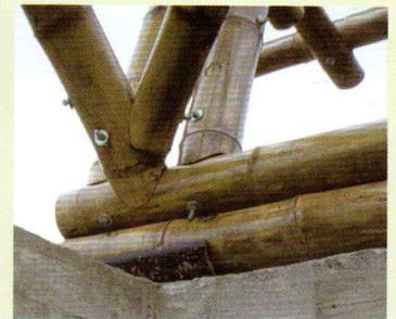
Estructura sobre soporte de hormigón armado y uniones mediante pernos metálicos.
